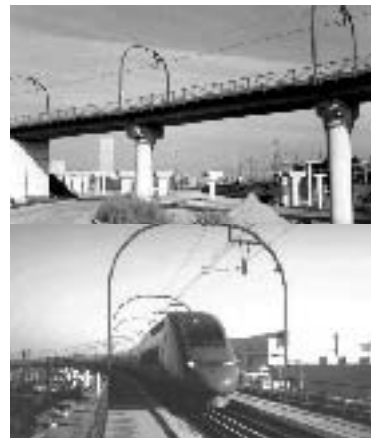
Viaduc TGV d'accès à la gare du midi
